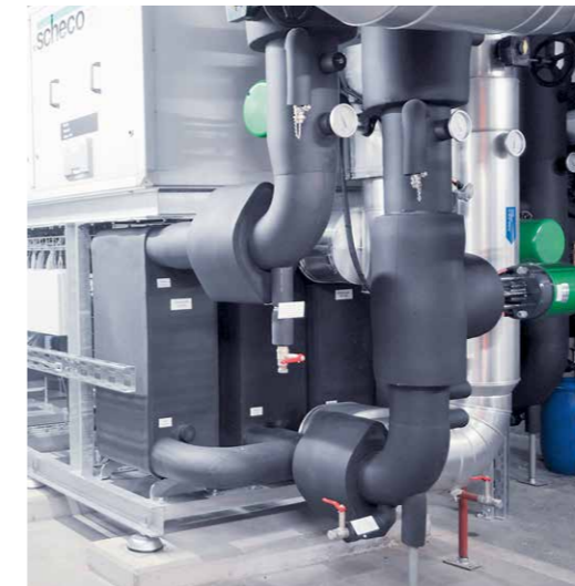
Kombinierte Wärmepumpe/Kältemaschine
