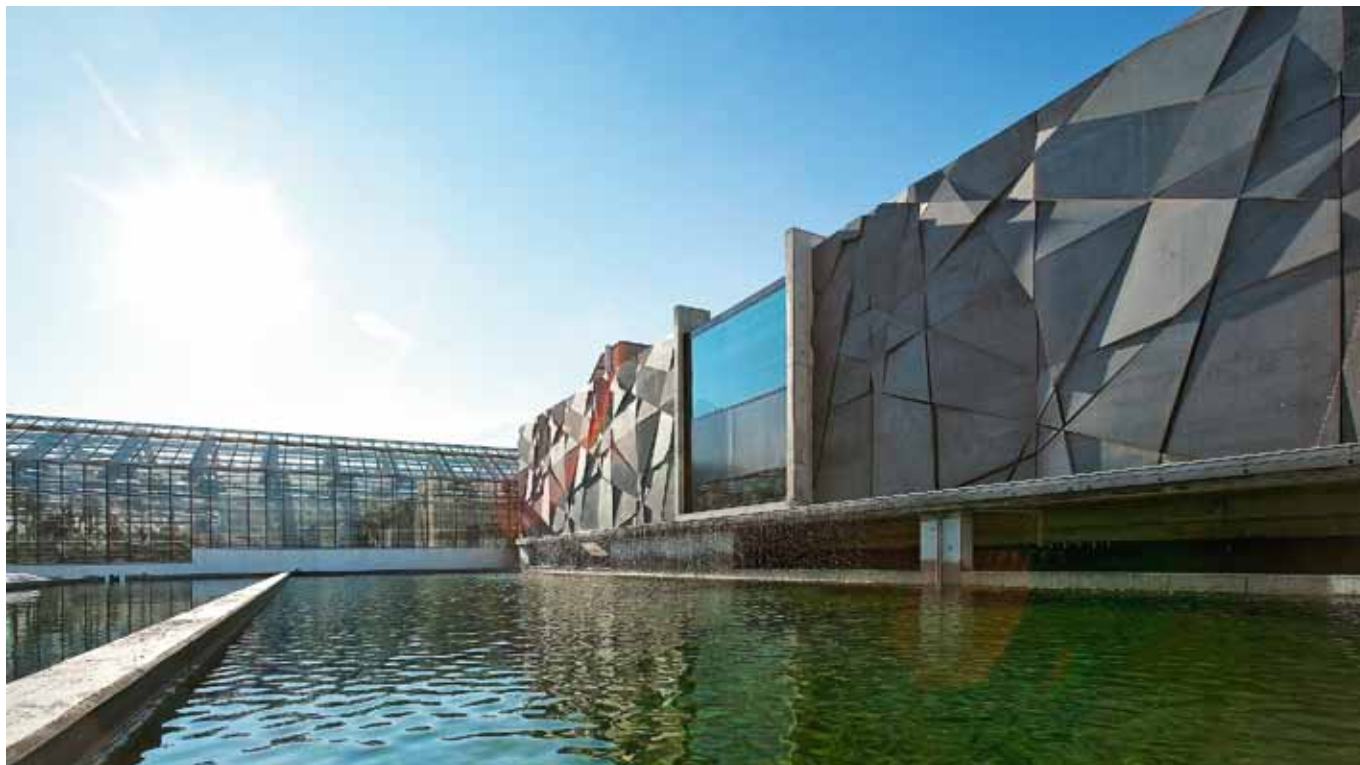
Bei anspruchsvollen Projekten sind die Vorteile mit BIM offensichtlich, wie beispielsweise beim Tropenhaus Frutigen.
